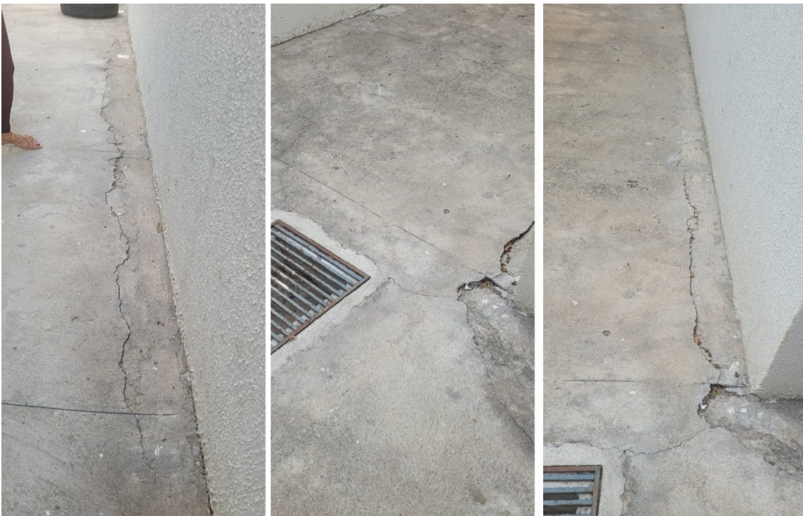
Piso externo parte de trás da escola.
