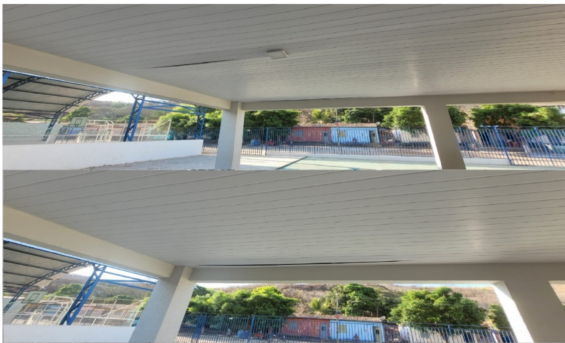
Forro do Refeitório
