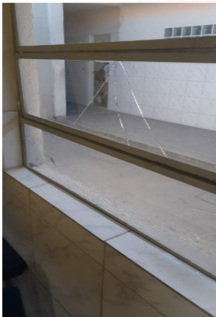
07 - janela sem vidro
